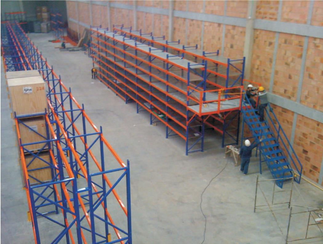
Permite el desplazamiento de varios operarios al interior de la estructura, lo que disminuye los tiempos de operación. Este sistema permite una zona de picking o preparación de pedidos. Se puede diseñar de acuerdo a las necesidades o características de los productos a almacenar.
